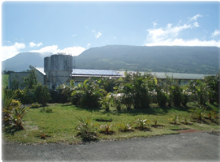
Figure 17 : Bâtiment d'élevage de poulets de chair (I.Henry, 2008)
