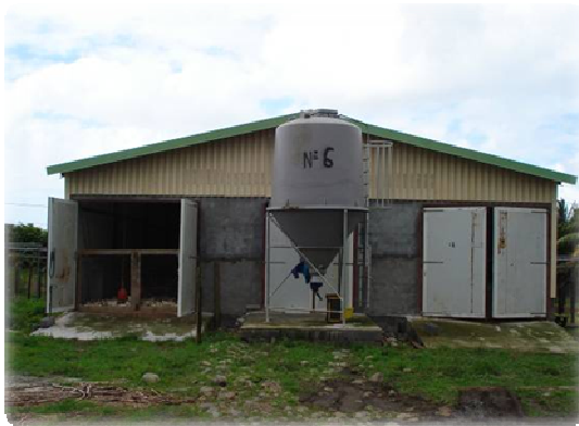
Figure 13 : Bâtiment de type « Péi », vue d'extérieur (I.Henry, 2008)
