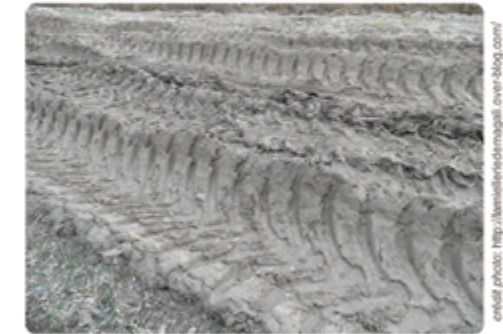
Ornières superficielles sur sol limoneux
